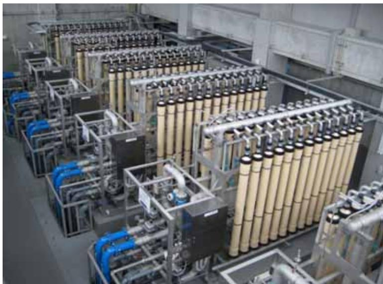
余市川浄水場では、それまでの「ろ過砂を使った急速ろ過方式」から、「膜ろ過方式」による処理へとろ過方法が切り替わりました。
