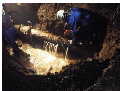
実際の漏水事故の復旧状況(平成 27 年 5 月:富沢町 8 丁目 口径 250 mm 配水管)
