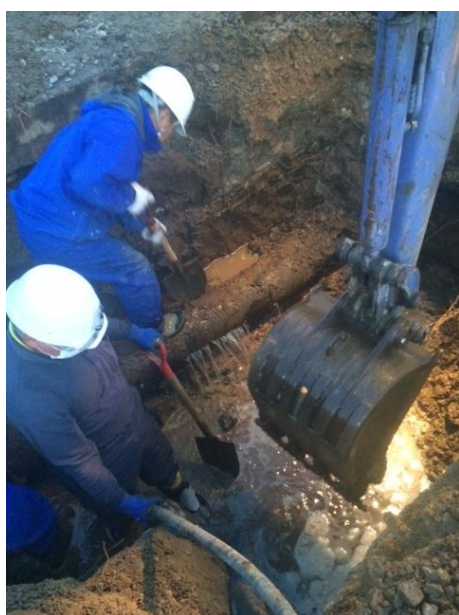
実際の漏水事故の復旧状況(平成 27 年 5 月:富沢町 8 丁目 口径 250 mm 配水管)
