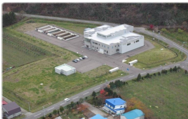
余市川浄水場全景
