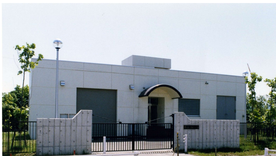
黒川第1中継ポンプ場
