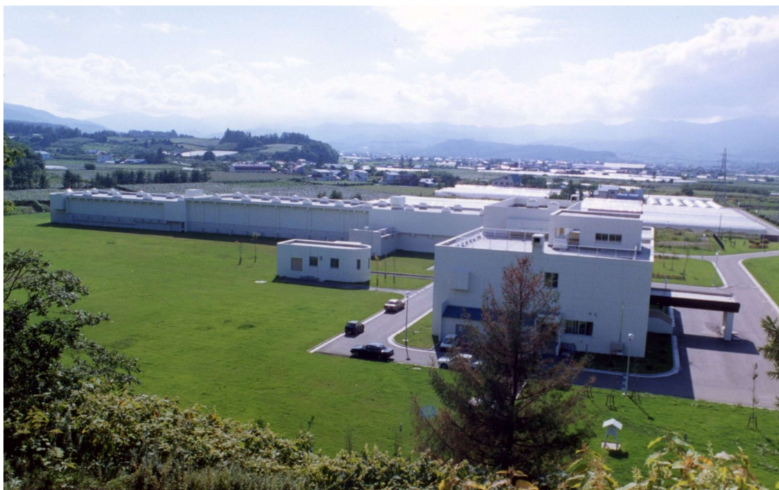
余市下水処理場
