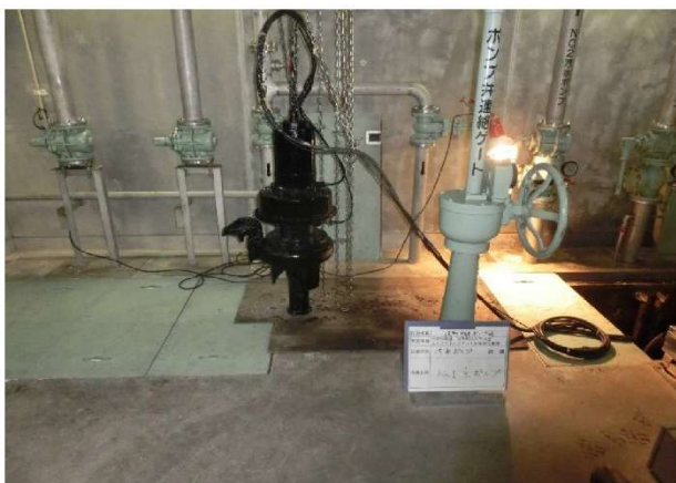
沢町中継ポンプ場ポンプ設備の状況 (適正な維持管理により現状では比較的良好)
