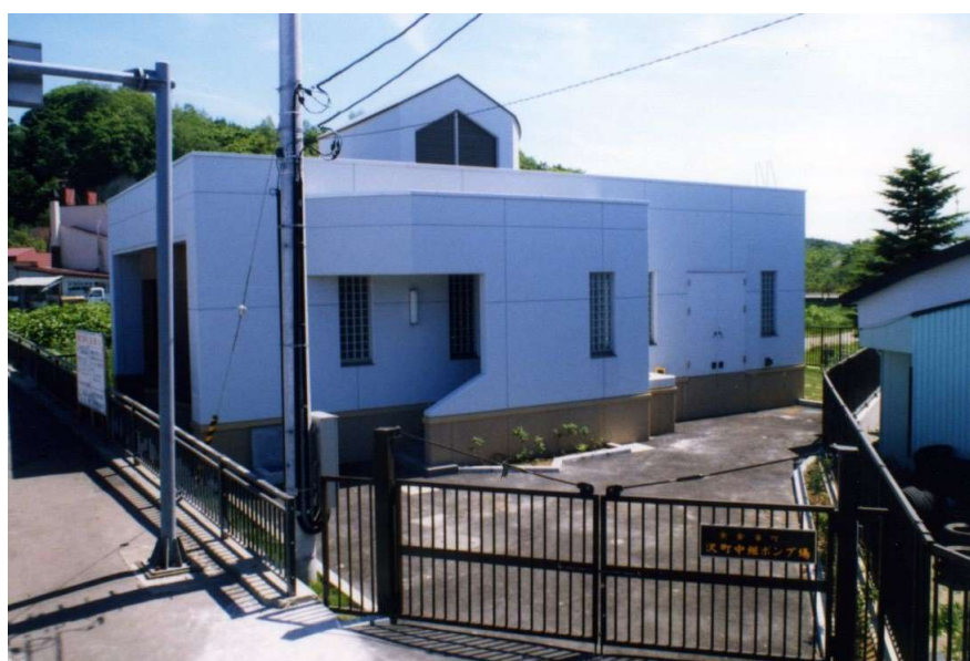
沢町中継ポンプ場
