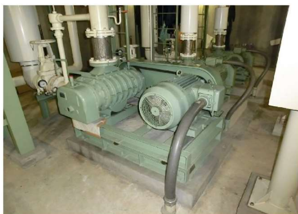
下水処理場送風機本体の状況 (適正な維持管理により現状では比較的良好)
