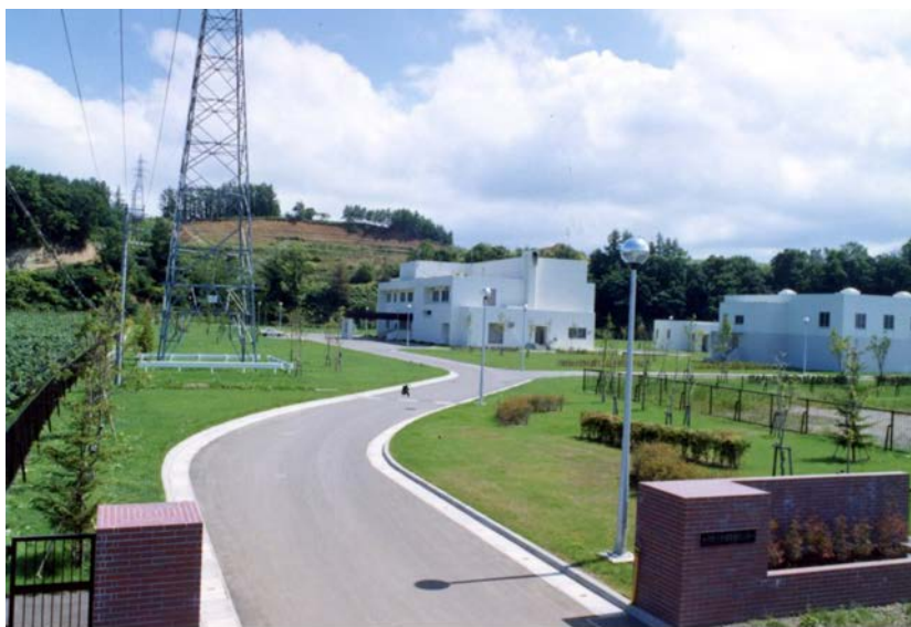
余市下水処理場
