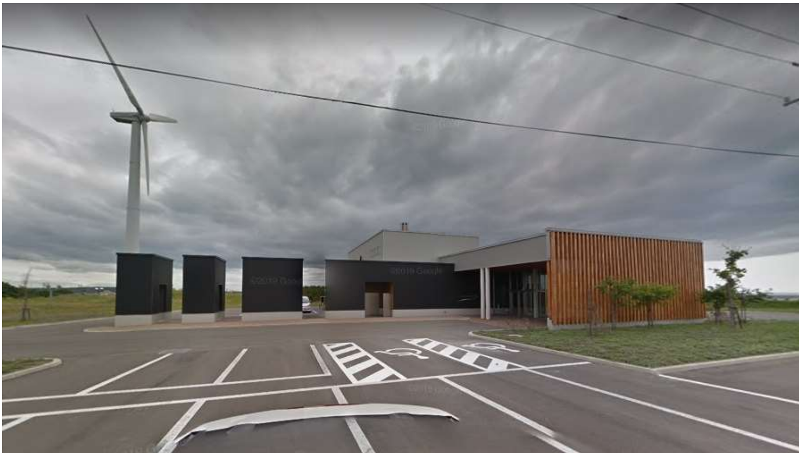
平成24年度供用 人体炉2基
