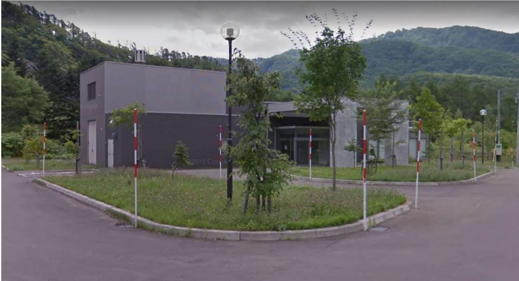
平成17年度供用 人体炉 1 基
