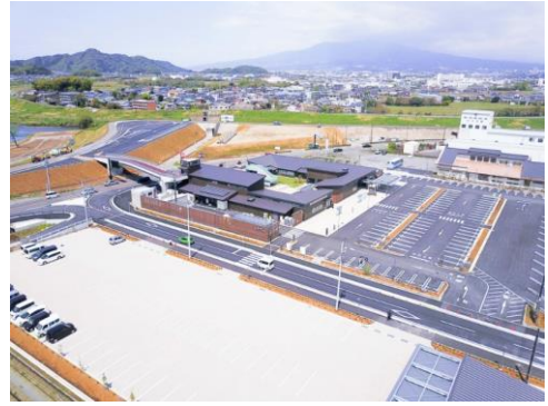
図表 6-1 道の駅全景 (出典：函南町 HP)
