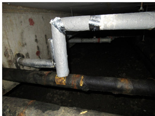
トイレ床下配管 (C評価)
