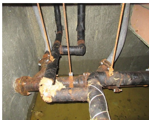
トイレ床下配管（C評価）
