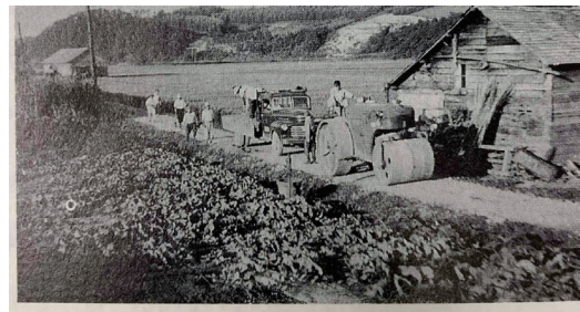
▲ 写真 道路の改修工事（『登郷土誌』）
